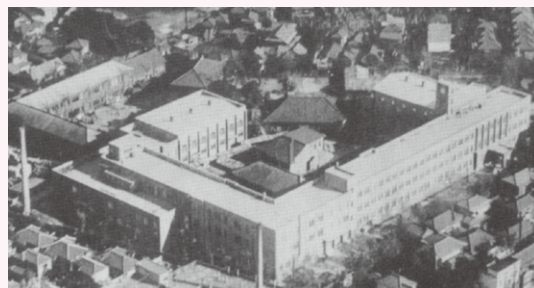
⑤完成直後の鉄筋校舎
