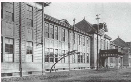
③完成した新校舎
